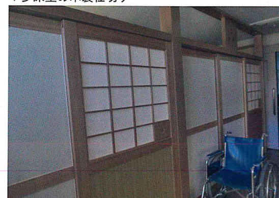
▼多床室の木製仕切り
