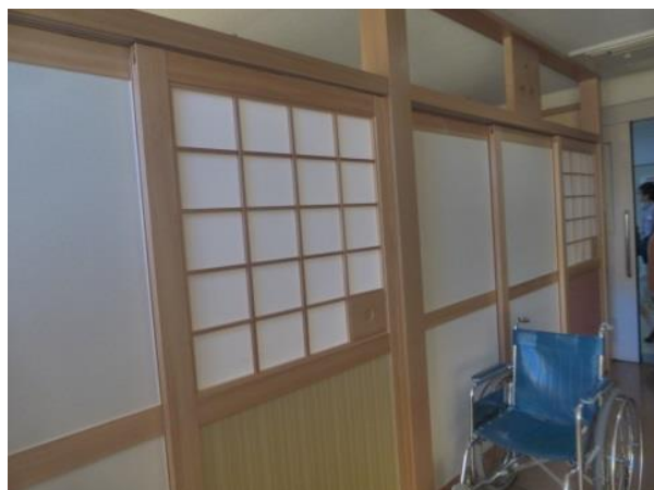
四人部屋は木製の引き戸の間仕切り
